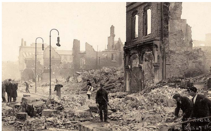
Shkatërrimet gjatë luftimeve për pavarësinë e Irlandës
